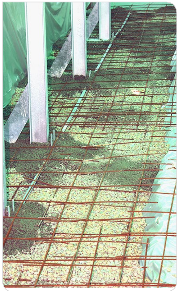
Abbildung 10 – Giessen des Betonplatte (b)
