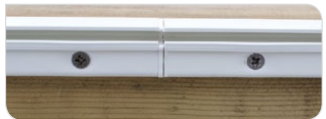
Abbildung 28 – Klemmprofil bündig mit der Beckenoberkante abschließen
