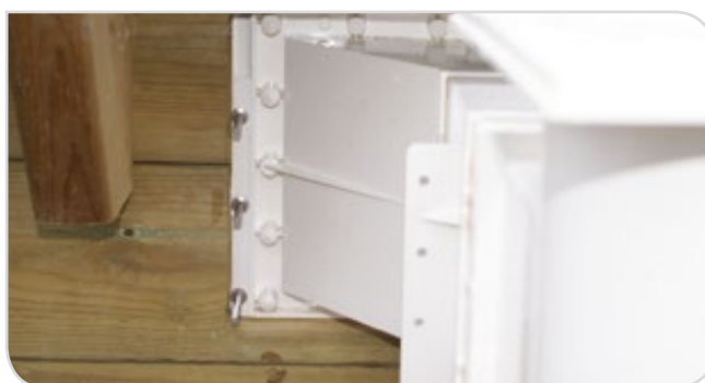
Abbildung 34 – Befestigung des Skimmers
